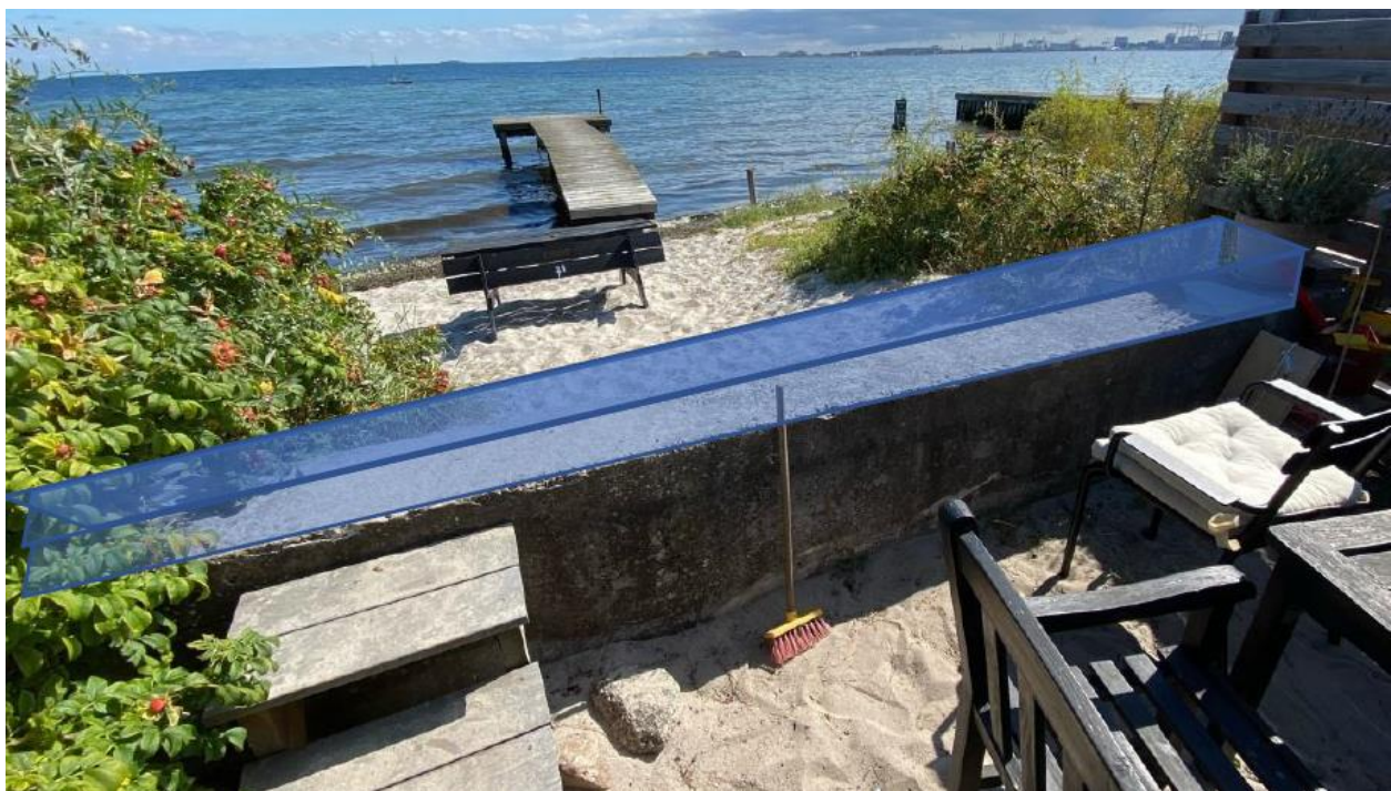
Figur 2. Billede af eksisterende mur med illustration af azobetræ
