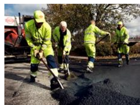
Det er vigtigt, at afspærringen ikke flyttes eller fjernes, da den er der både for at beskytte de folk, der arbejder på stedet og trafikanterne i området og for at undgå, at du og dine kæledyr får sorte poter
