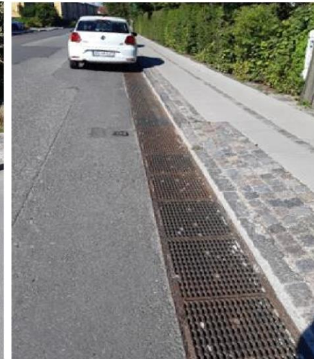
Regnvand løber i fortov i overdækket afløb Regnvand løber i riste langs vejen
