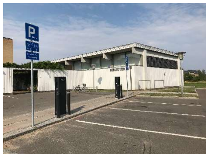
Ladestander ved Jægersborg Bibliotek.
