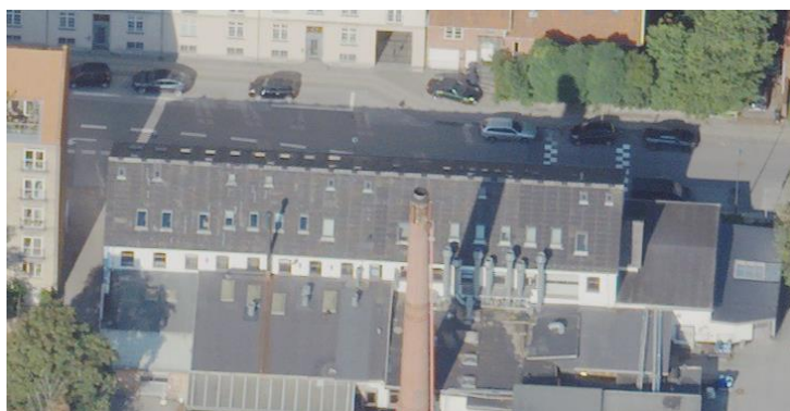
Bygning 1 set fra "baggården"
