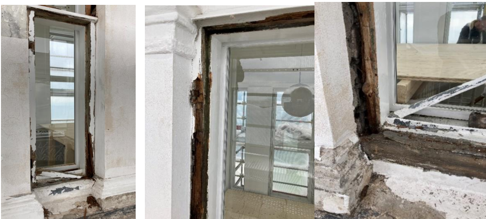
Gående ramme taget af hængsler. Karme mod murværk fremstår med omfattende og dybe rådskader mod murværk, i hele længden. Den forreste del af karmen, vinduesfalsen for vinduet, er stort set forsvundet.
