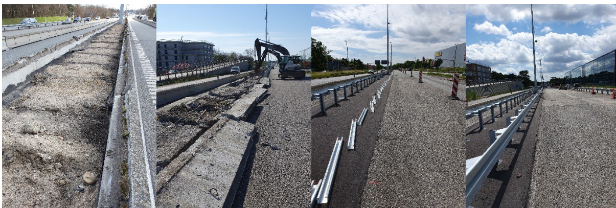
På billederne kan betonautoværne ses efter det har fået fjernet betonaftdækninger (låg), under nedbrydning og endeligt opsætning af det nye stålautoværn og det færdige stålautoværn.
