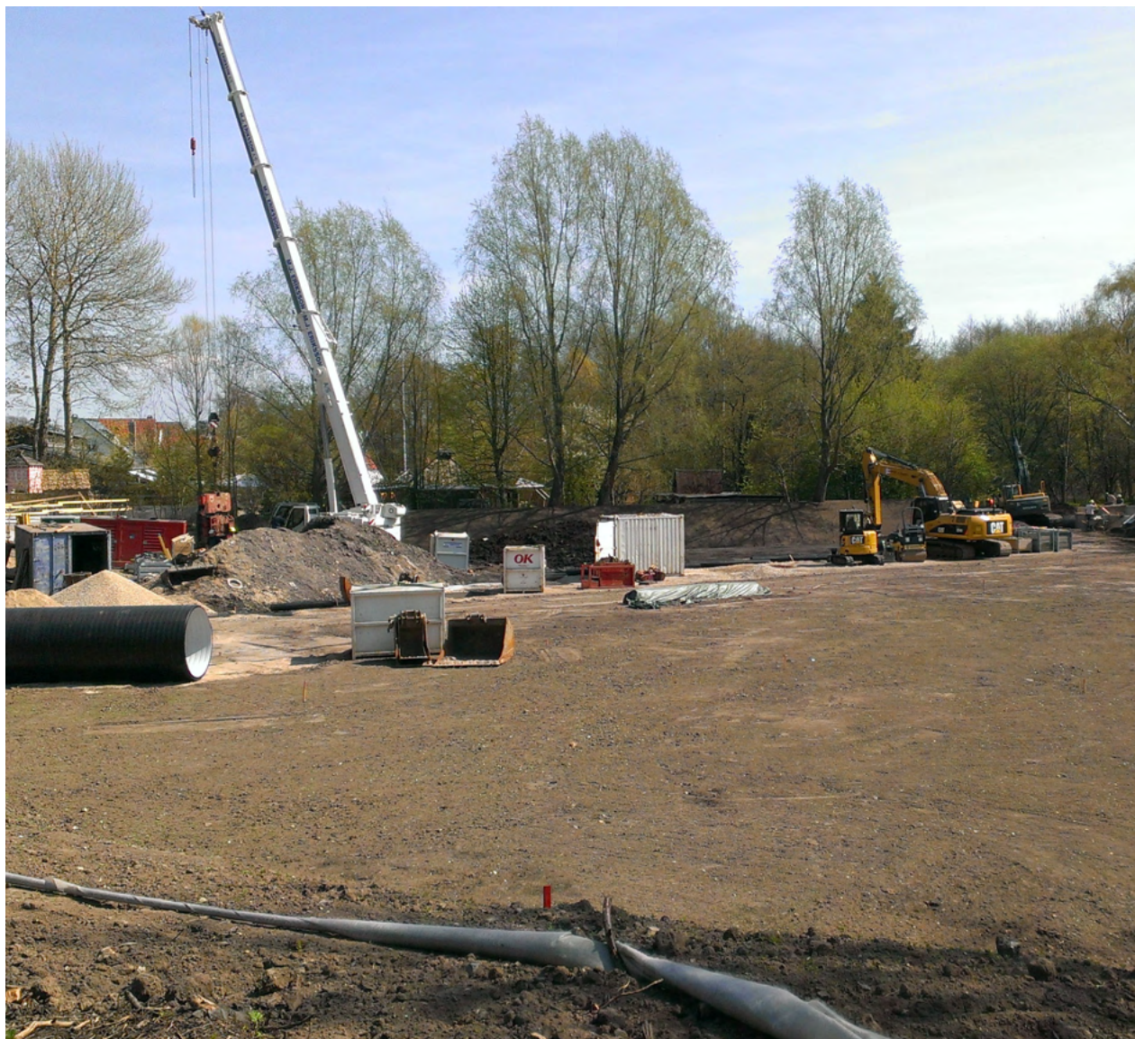
Anlæg af Brogårdsbassin
