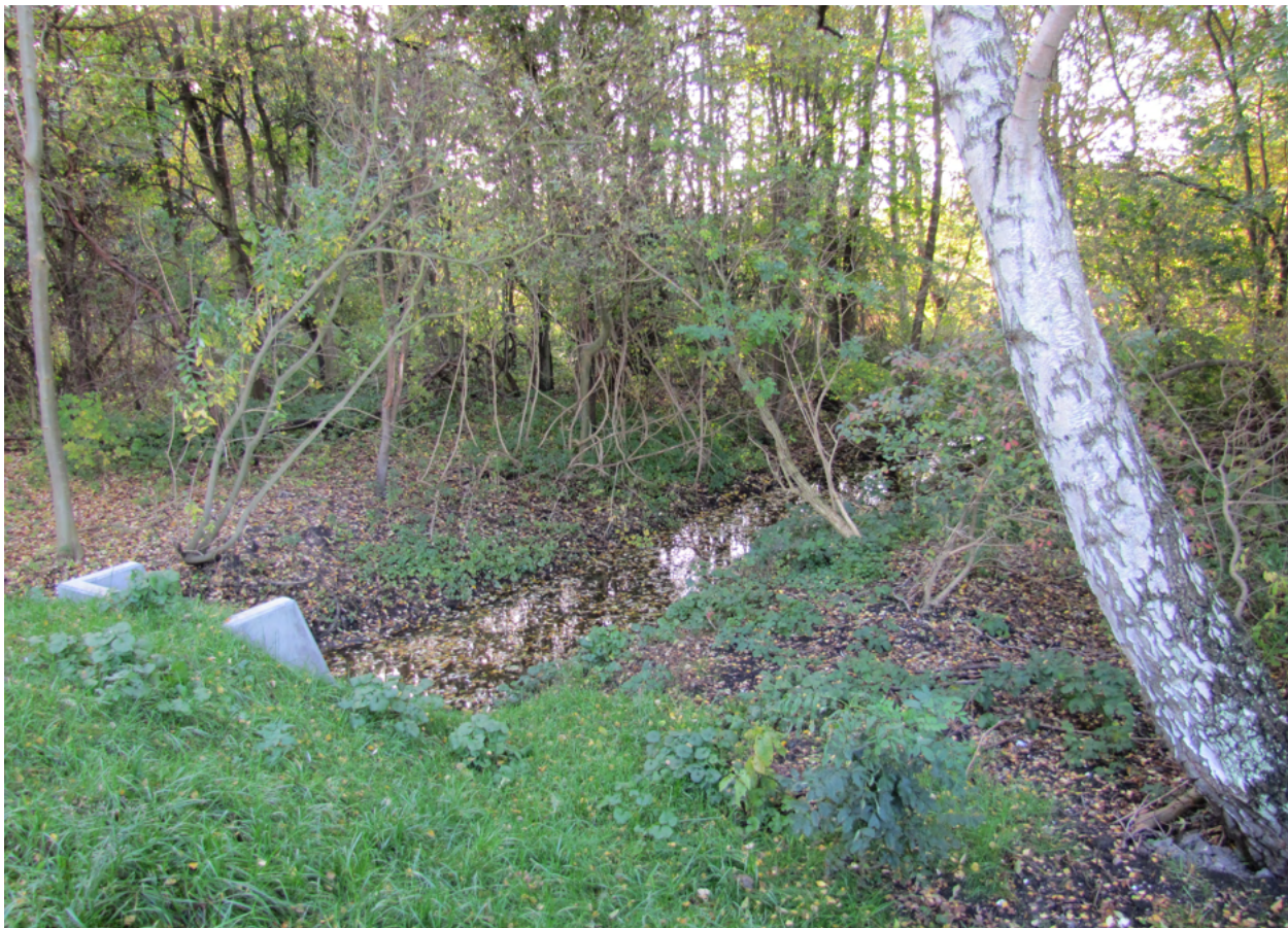
Overløb til Brobækken fra Brogårdsbassin
