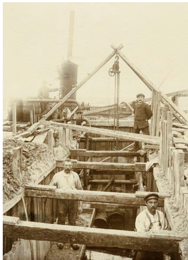
Kloakudløbsledning ved Skovshoved under støbning 1935
