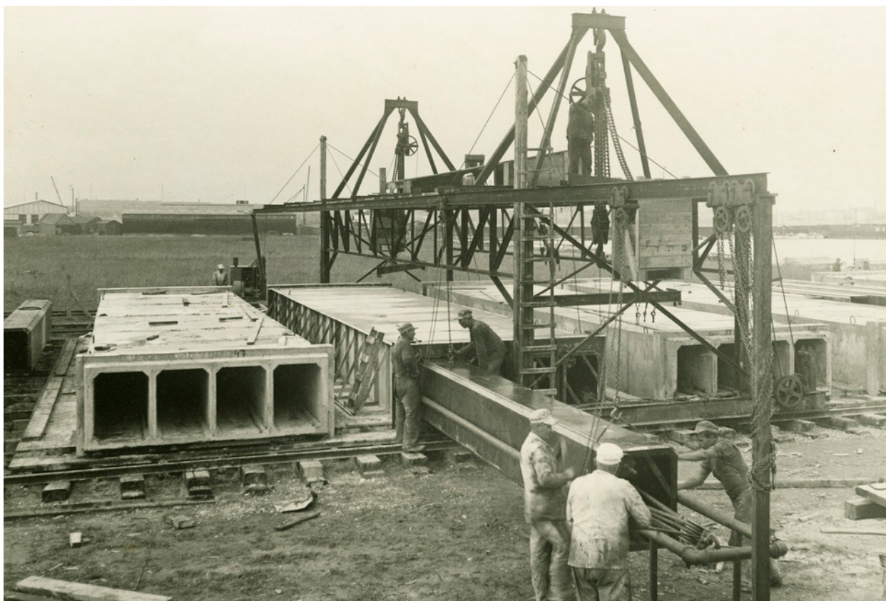
Kloakudløbsledning ved Skovshoved under støbning 1935
