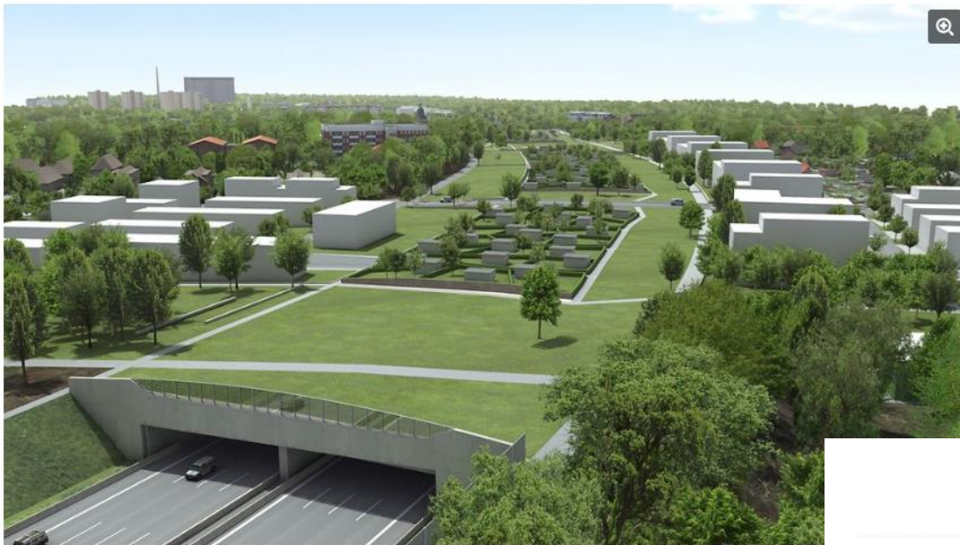
Künftiger Tulleleingang: anspruchsvolle Gestaltung der Lärmschutzbauwerke Bild: © DEGES/V-KON.media
