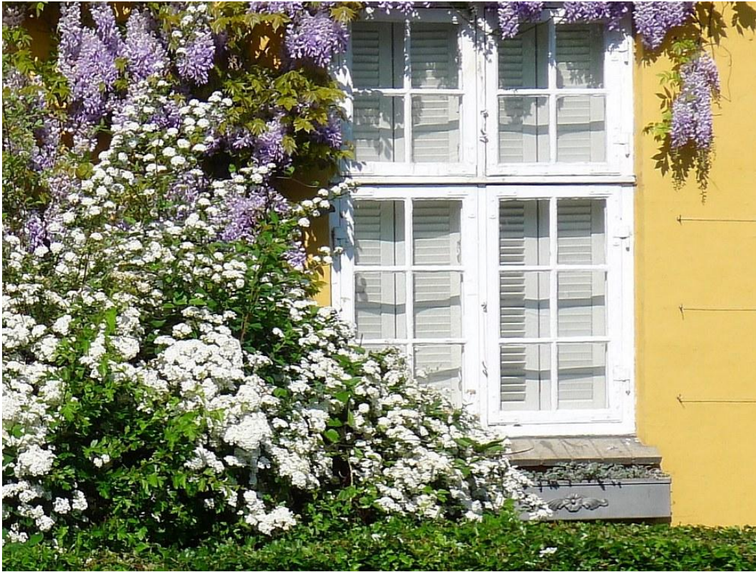
Jægervangen, miljørigtig istandsættelse af oprindelige vinduer.
