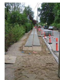
Det er ikke muligt at køre ind på din grund, imens fortovet udføres, da det vil ødelægge entreprenørens arbejde og din bils undervogn
