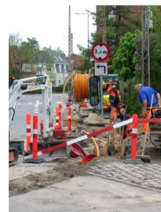
Det er vigtigt at afmærkningen ikke flyttes eller fjernes, da den er der både for at beskytte de folk, der arbejder på stedet, og trafikanterne i området
