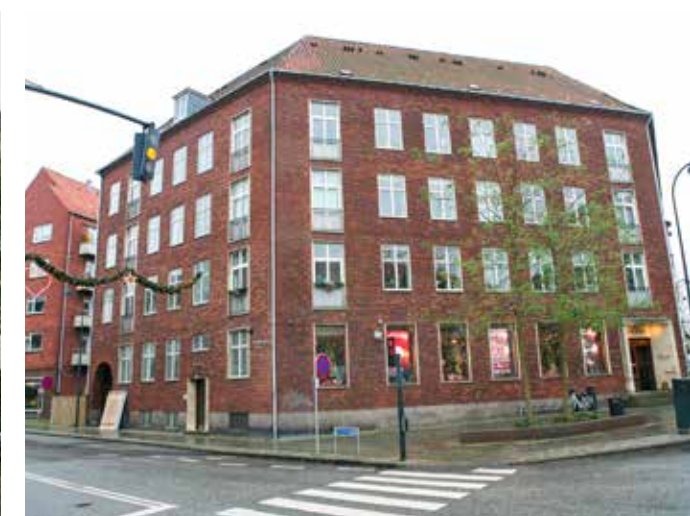
⑥ Fra kryds mellem Baunegårdsvej og Gentoftegade
