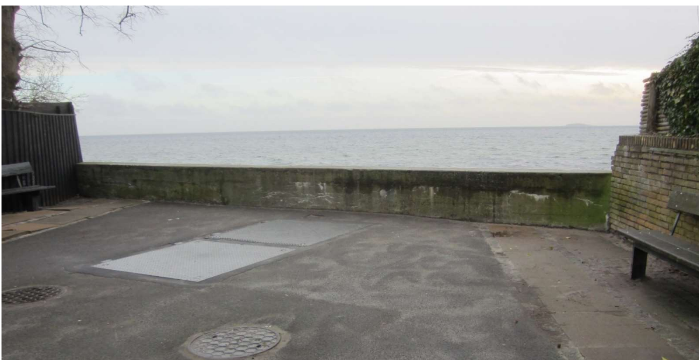
Annasvej/Bengtasvej, fotobilag af betonstøttemur mod Øresund, vestside.
