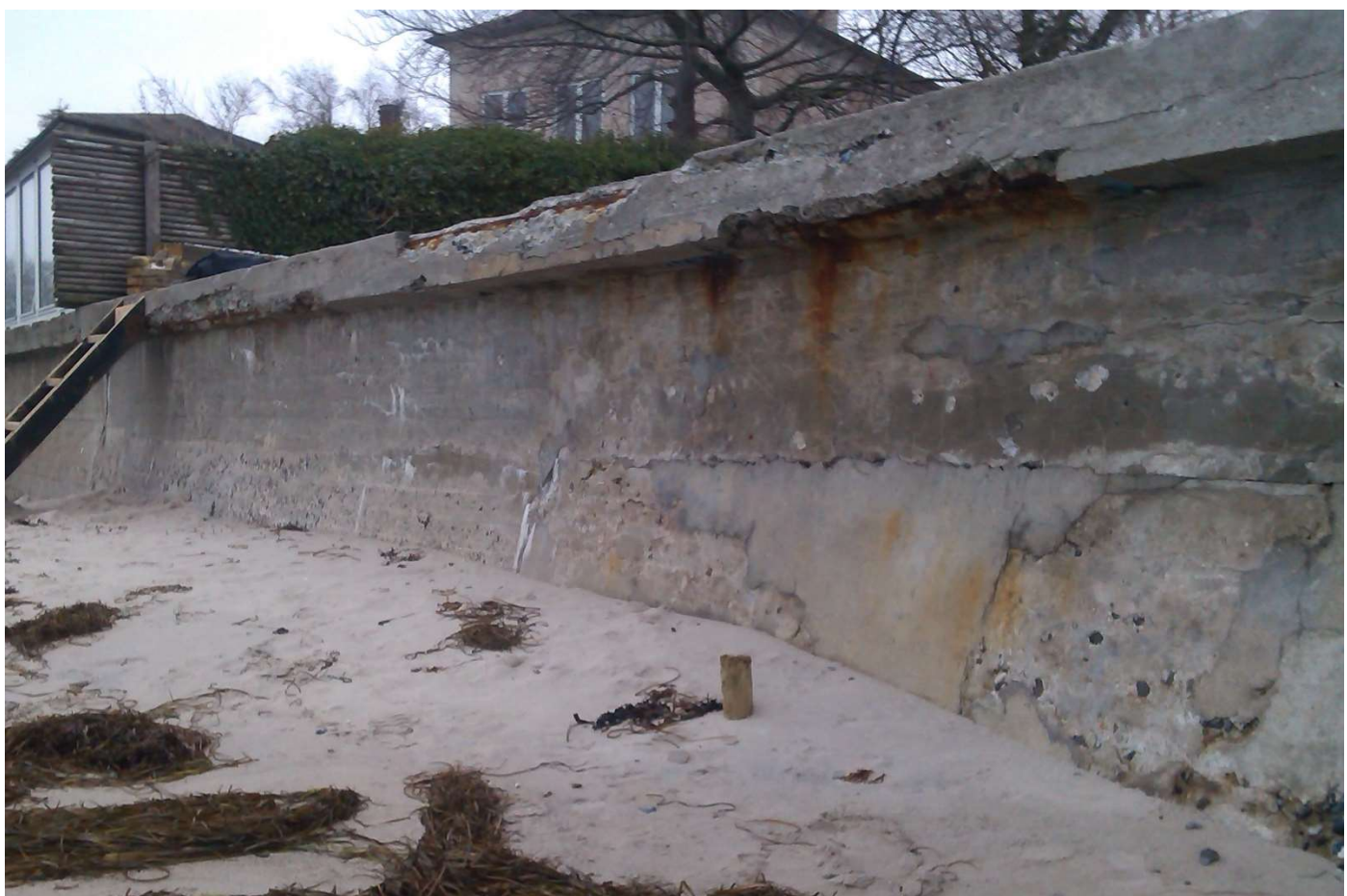
Annasvej/Bengtasvej, betonstøttemur mod Øresund, østside.
