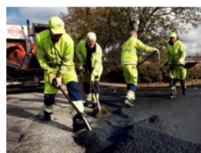
Det er vigtigt, at afspærringen ikke flyttes eller fjernes, da den er der både for at beskytte de folk, der arbejder på stedet og for trafikanterne i området og for at undgå, at du og dine kæledyr får sorte poter
