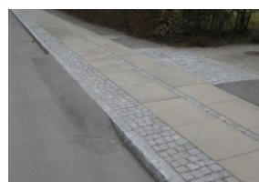
Din rampe består af to lag, en bærende kerne og et fint slidlag som udlægges i to arbejds-gange, og derfor kan der mangle et par cm, indtil slidlaget er kommet på.
