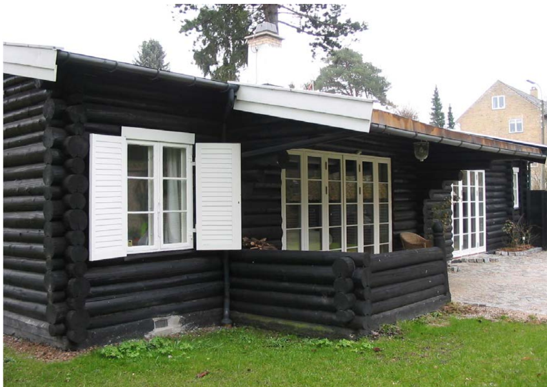
Oprindeligt bjælkehus - vestfacade
