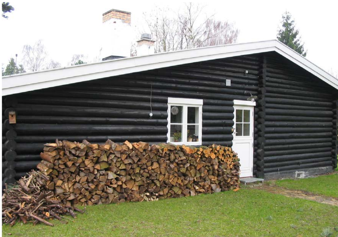
Oprindeligt bjælkehus – nordfacade
