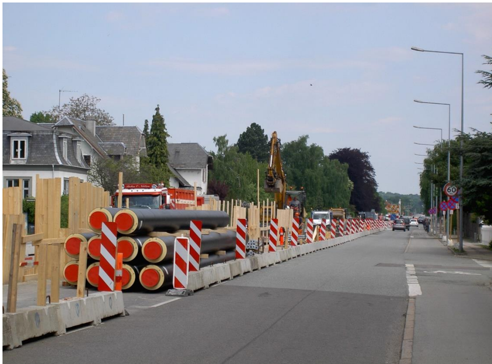
Foto: Fjernvarmearbejde på Bernstorffsvej
