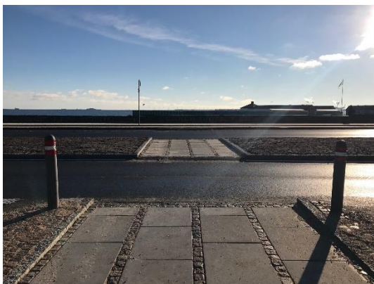
Ny kantstensafgrænsning helle nord for Charlottenlund Strandpark.
