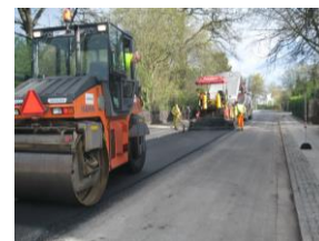
Flyt din bil imens arbejder pågår, der er ikke plads til den, når maskinerne kommer
