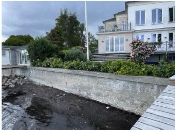
Figur 1: Eksisterende støttemur der skal renoveres set fra øst mod vest, sydlig ende.
