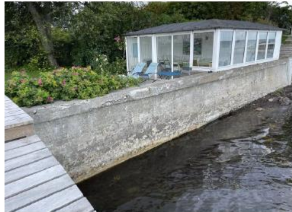
Figur 2: Eksisterende støttemur der skal renoveres set fra øst mod vest, nordlig ende.
