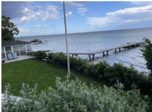
Figur 3: Eksisterende støttemur der skal renoveres, befinder sig på den anden side af rosenbedet, set fra vest mod øst.
