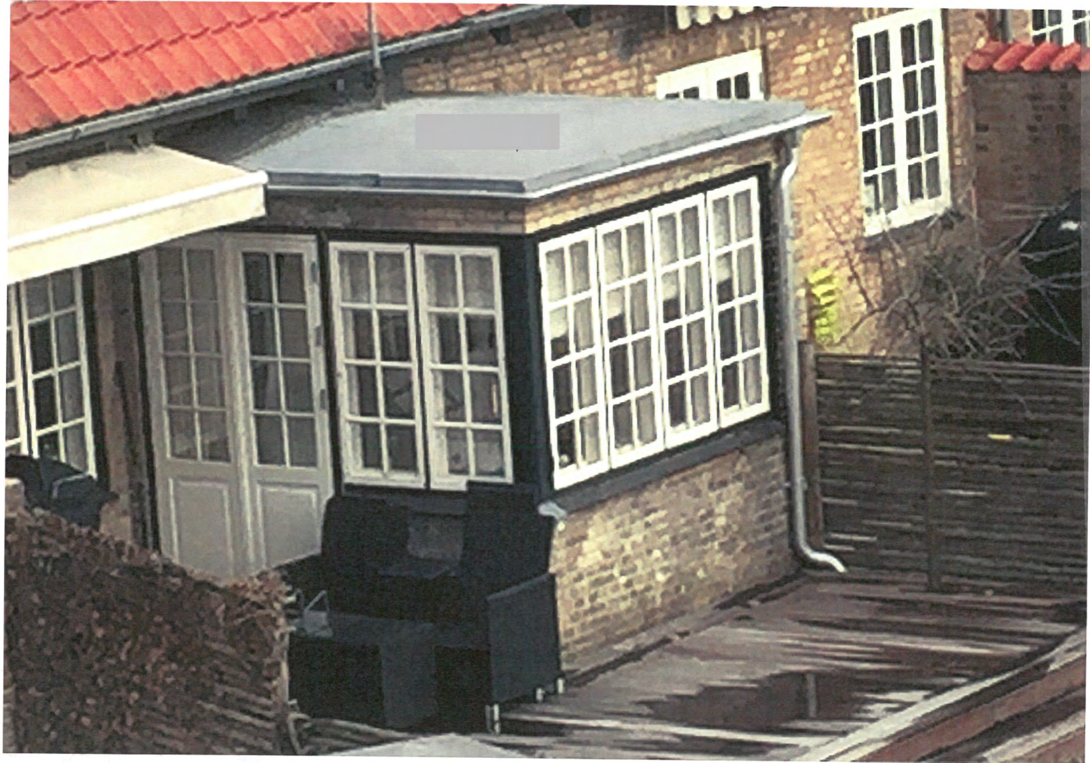
Bevaringsværdig havestue på Banevej.
