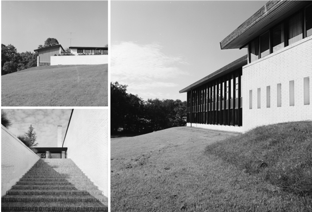
Det hvide murværk, den sorte stolpekonstruktion i træ, udfyldningsfelter i træ og belægninger med tegl er karakteristiske materialer for bebyggelsen. Bygningen til højre er udpeget som bevaringsværdig i lokalplanen.
