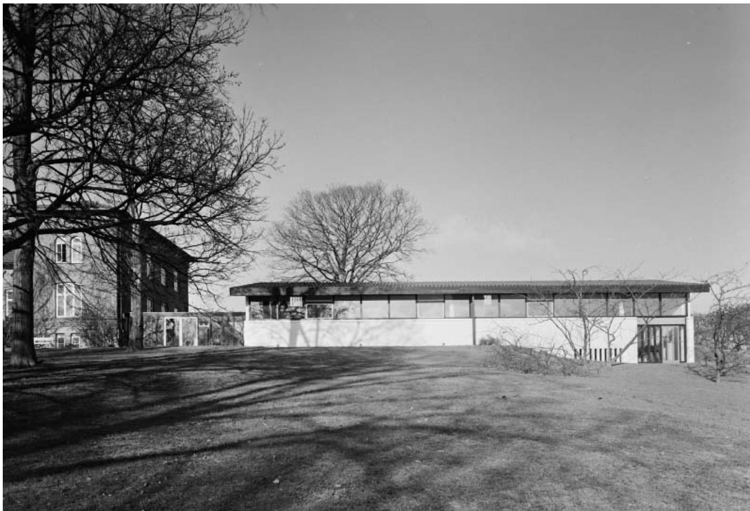
Bygningen til højre, er opført i midten af 1960'erne ved udvidelsen af havebrugshøjskolen og er udpeget som bevaringsværdig i lokalplanen. Bygningen til venstre, opført i 1800-tallet, blev revet ned i bebygningen af 1980'erne.
