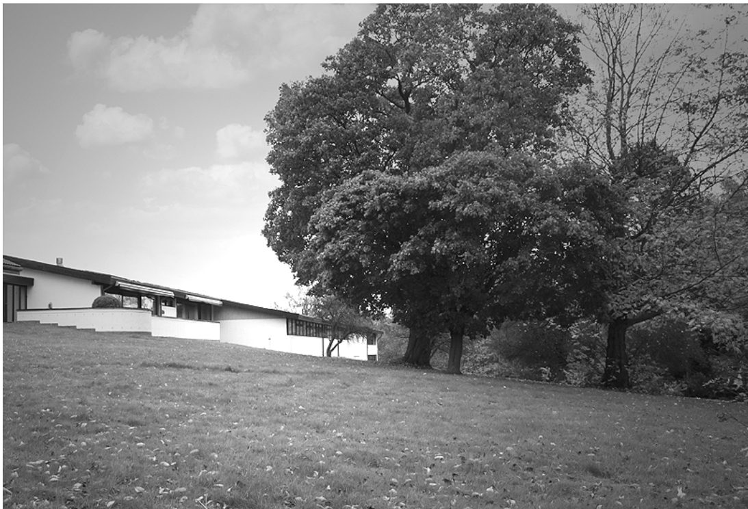
De lave taghældninger skaber en fin sammenhæng til landskabet - bygningerne "lægger" sig i landskabet. Begge bygninger er udpeget som bevaringsværdige i lokalplanen.
