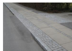
Din rampe består af to lag, en bærende kerne og et fint slidlag som udlægges i to arbejds-gange, og derfor kan der mangle et par cm, indtil slidlaget er kommet på.
