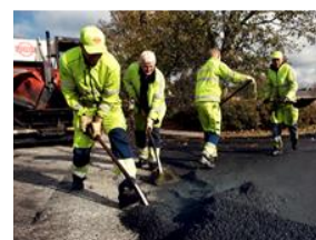
Det er vigtigt, at afspærringen ikke flyttes eller fjernes, da den er der både for at beskytte de folk, der arbejder på stedet og trafikanterne i området og for at undgå, at du og dine kæledyr får sorte poter
