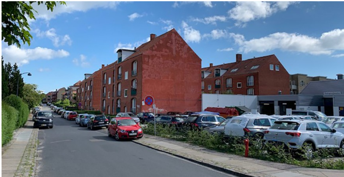
Eksisterende bebyggelse Broholms Allé
