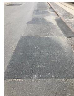
Kørebanerne reoveres med et nyt asfaltslidlag, fordi de er slidte, ujævne og præget af gravninger gennem tiden.
