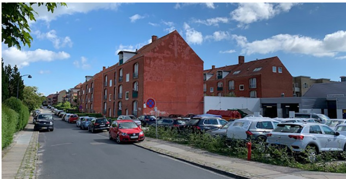
Eksisterende bebyggelse Broholms Allé
