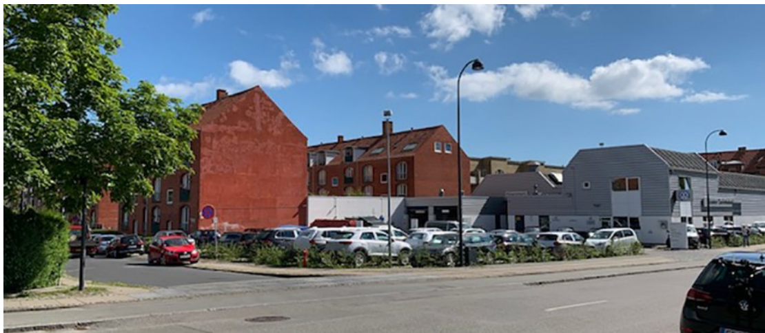
Lokalplanområdet set fra hjørnet Broholms Allé/Hyldegårdsvej.
