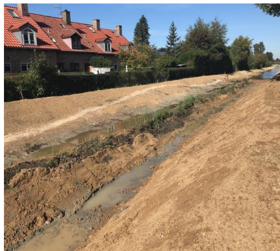
90% færdigt profil i den sydlige del af Gentofterenden.
