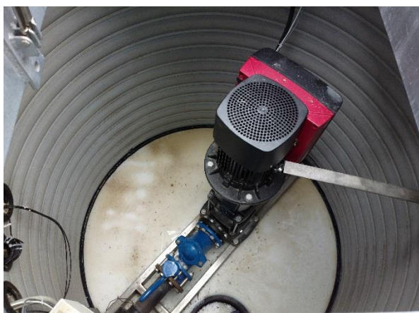
Et kig ned i brønd med shunt på hjørnet af Enighedsvej og Bernstorffsvej. Foto: GGF
