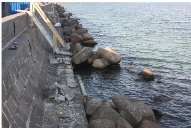
Stenkastningen er fjernet, så forkanten af glaciset kan repareres.
