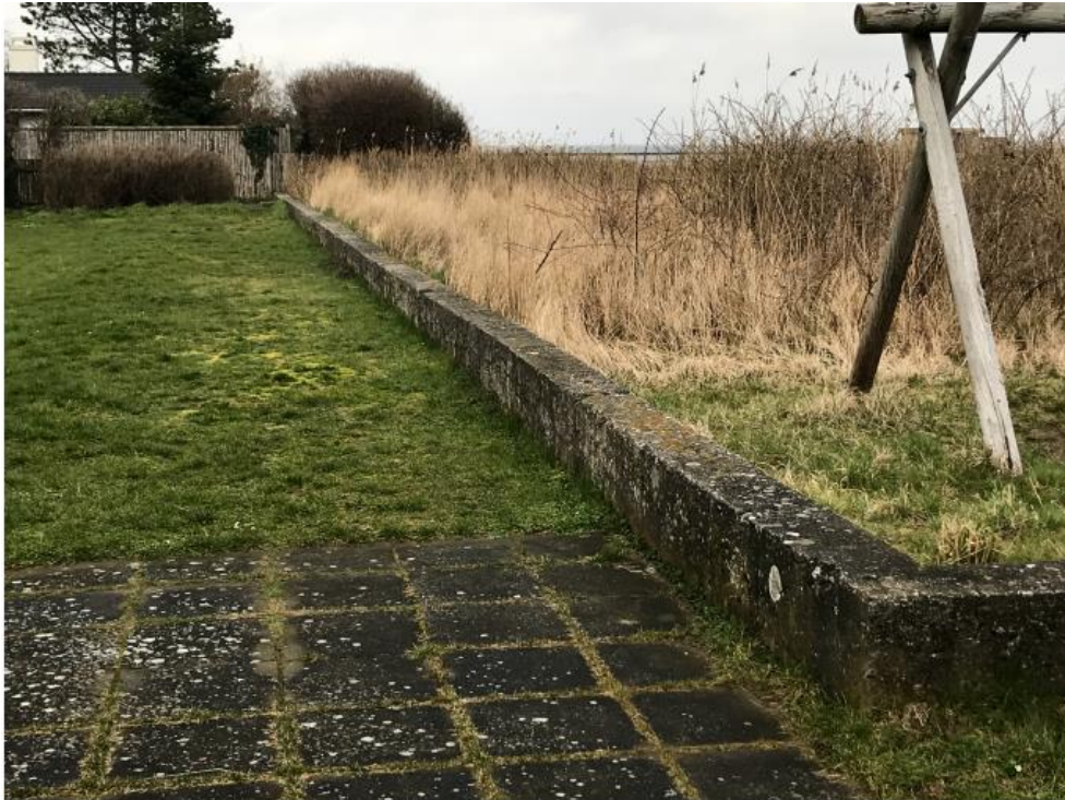
Figur 2 Billede af eksisterende kystsikringsmur langs fodboldbanen ved matrikel 33f
