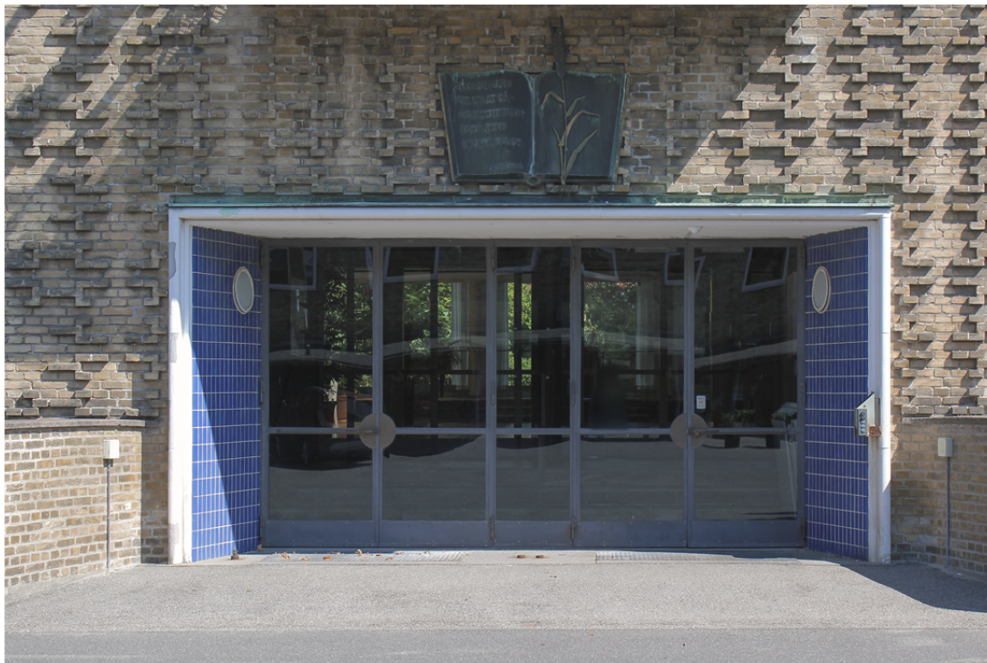
Hovedbygningens hovedindgang, omkranset af mønstermurværk. Bag glasdørene anes den tidligere skoles fællessal.
