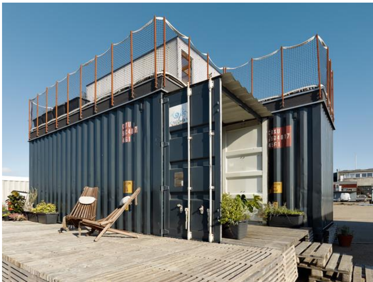
Container terrasse Refshaleøen, Københavns kommune
