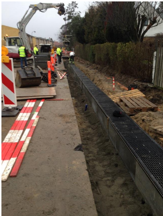
Sætning af vandrender på Mosegårdsvej.
