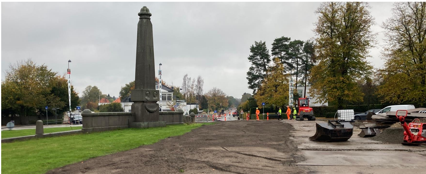
Foto: Hovedrøret er lagt fra Bernstorffsvej gennem Femvejens rundkørsel og frem til Vilvordevej. Der skal nu asfalteres. Foto taget af Lasse Gorm Jensen.
