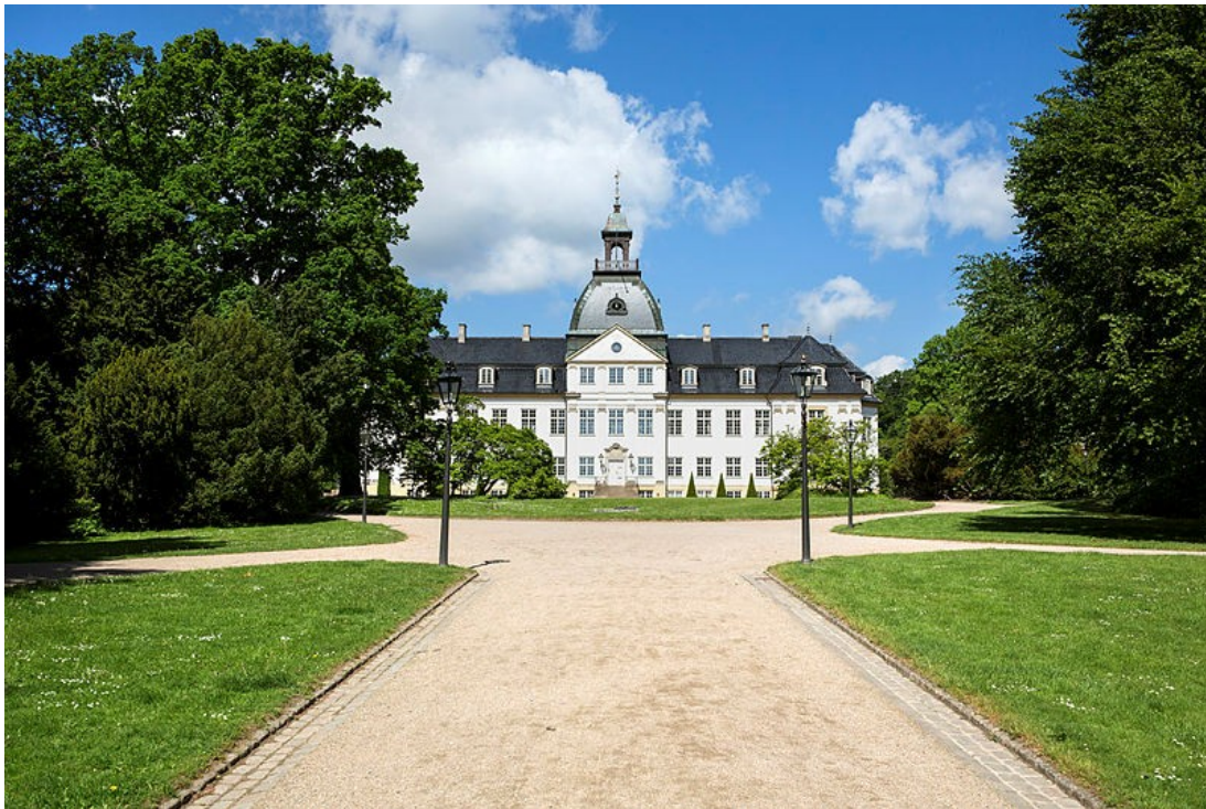
Charlottenlund Slot beliggende midt i den historiske akse.
