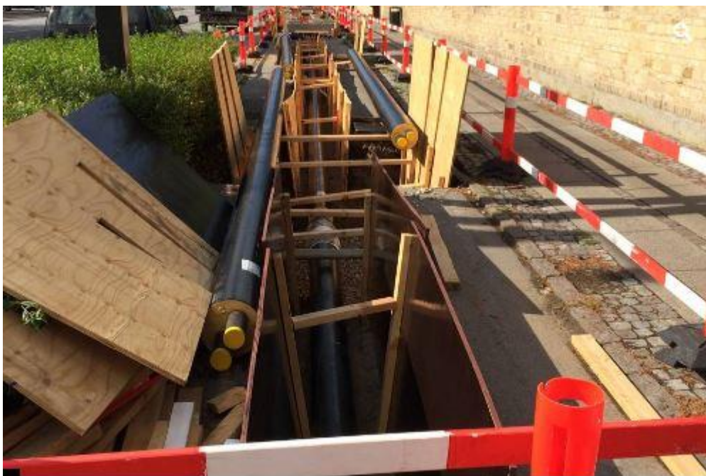
Foto: Tidligere udbygning af Fjernvarme i Gentofte Kommune. Foto af Hoffmann A/S
