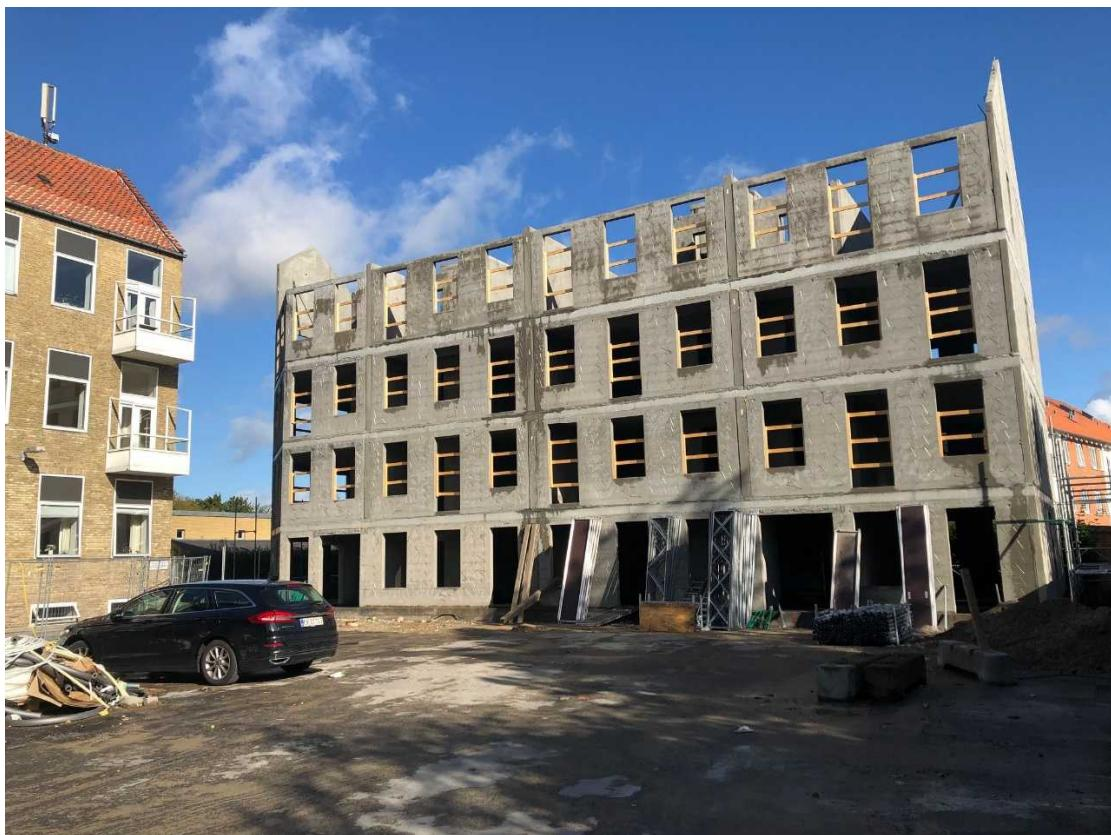
Figur 3. Status på byggeriet af bygning B, hvor alle betonelementer er monteret.
