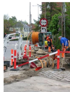
Det er vigtigt at afmærkningen ikke flyttes eller fjernes, da den er der både for at beskytte de folk, der arbejder på stedet, og trafikanterne i området
