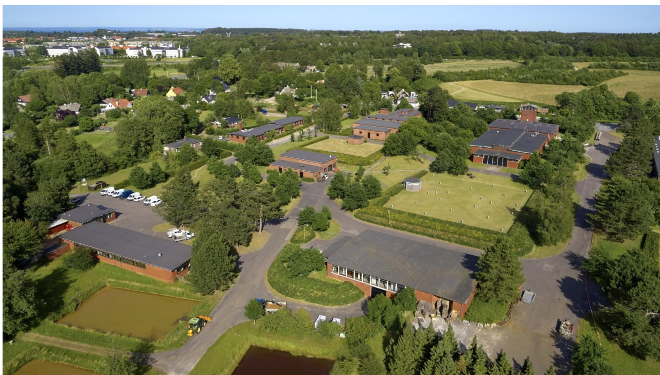
Figur 5.5 Sjælsø Vandværk beliggende på Ravnsnæsvej i Rudersdal Kommune
