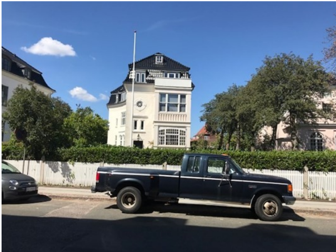
Bevaringsværdig villa Strandparksvej 7
