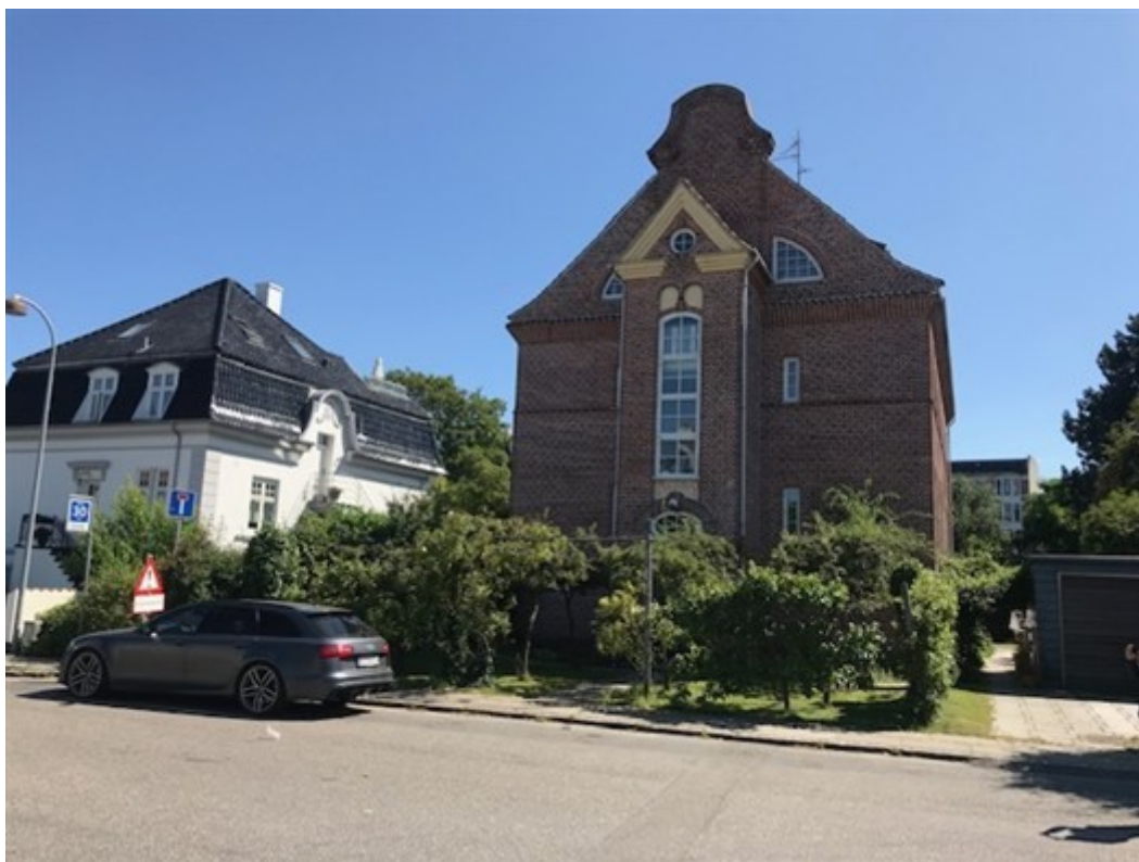
Den bevaringsværdige Villa Rødsten, Onsgårdsvej 12, arkitekt. P.V. Jensen Klint
