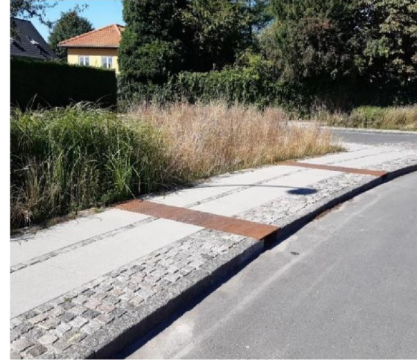
Regnvand løber i fortov i overdækket afløb Regnvand løber i riste langs vejen
